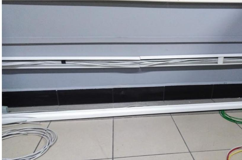
**Figura 4. 14 Enrutado de cable UTP**
