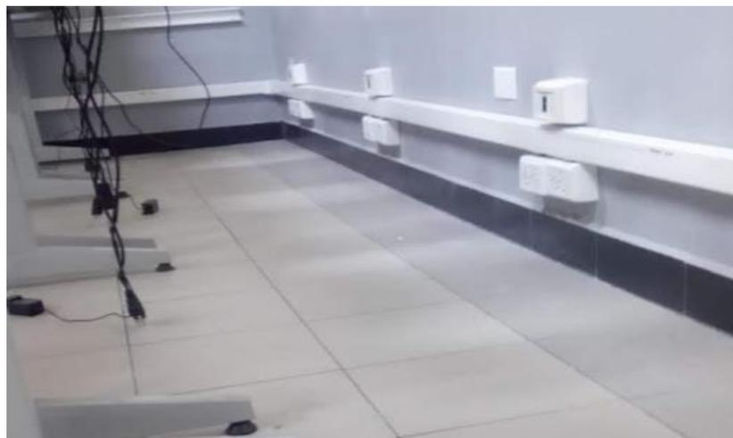
**Figura 4. 12 Colocación puntos de red y tomas eléctricos**
