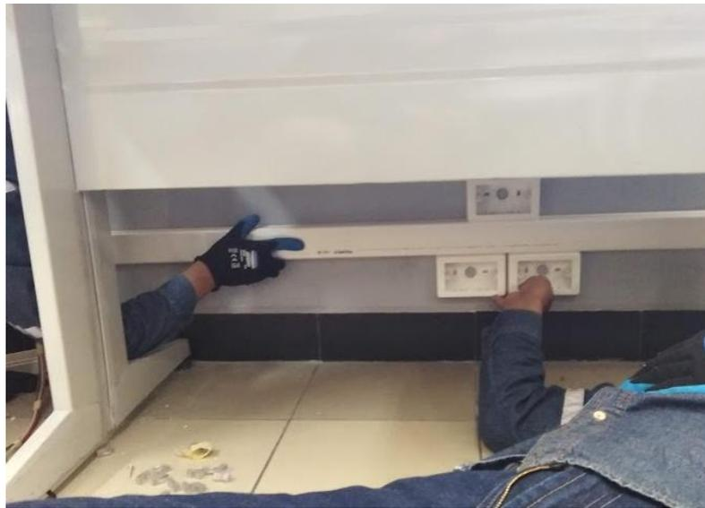
**Figura 4. 11 Colocación de canaletas**
