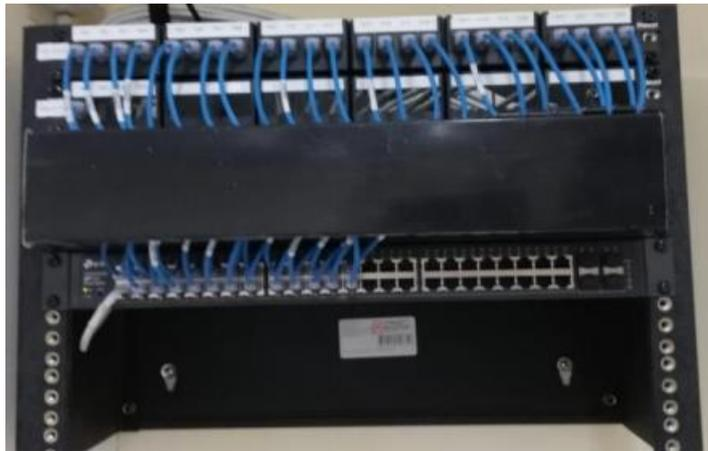
**Figura 4. 16 Montaje de *switch***
