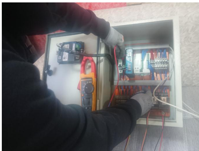
Figura 4.18 Pruebas de continuidad Fuente (Autor)
