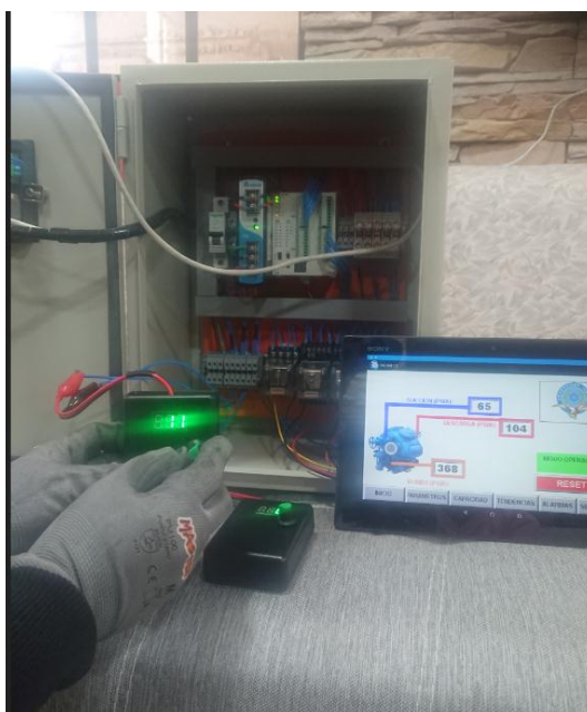
Figura 4.20 Pruebas de módulos de presión Fuente (Autor)
