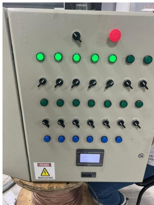
El HMI del sistema de control se encuentra localizado en la parte frontal del tablero de control, tal y como se muestra en la Figura 26, se eligió esta localización ya que el tablero de control se encuentra en un punto central y estratégico de la industria, por lo que, la manipulación de los elementos del sistema resulta práctica.
