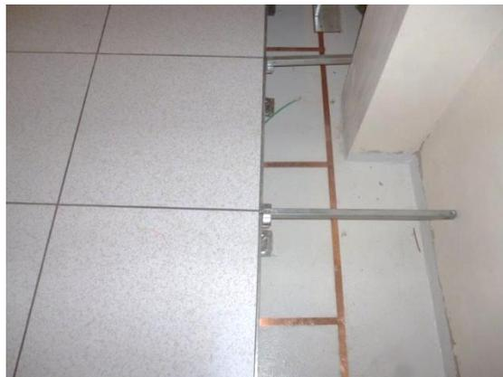
Figura 4. Malla de Alta Frecuencia, Data Center Fuente. (EL AUTOR, 2015)
