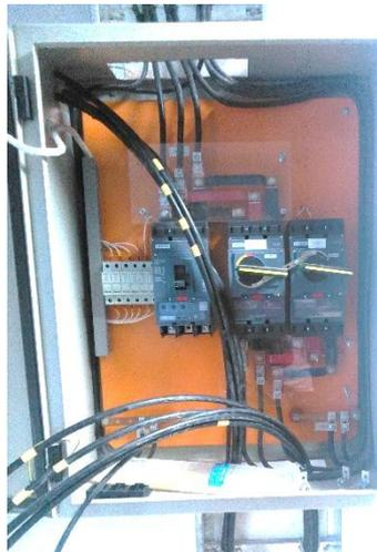
Figura 5. Tablero de ByPass con Acometidas
