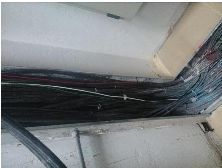
Figura 20. Alimentadores de Energía en Canaleta Metálica
