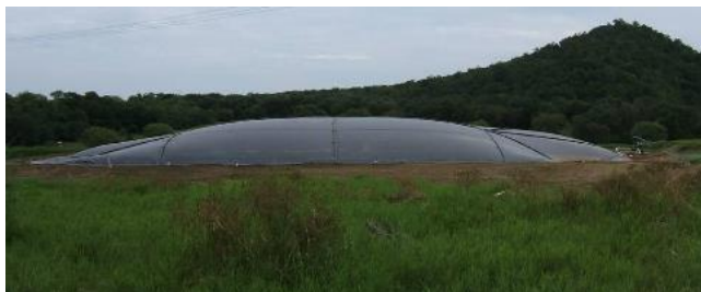
Figura 25 Biodigestor para tratamiento de aguas y estiércol
