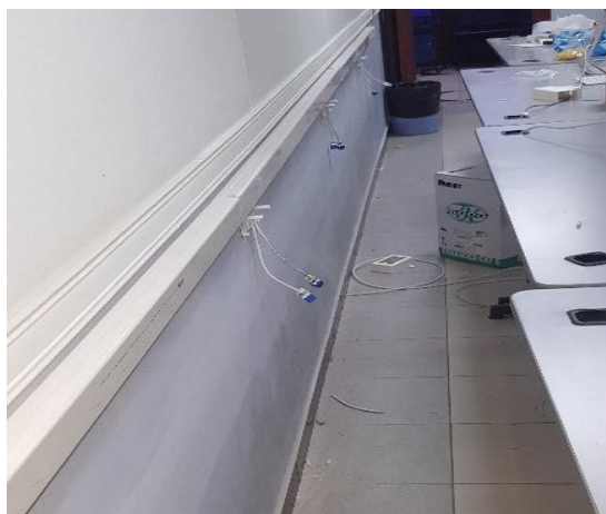
Figura 3.11 Instalación Canaletas (Israel, 2017)
