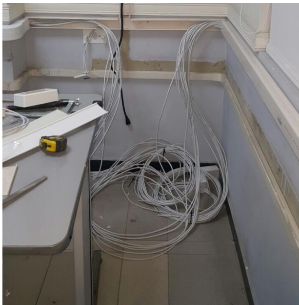
Figura 3.9 Retiro cables y canaletas (Israel, 2017)
