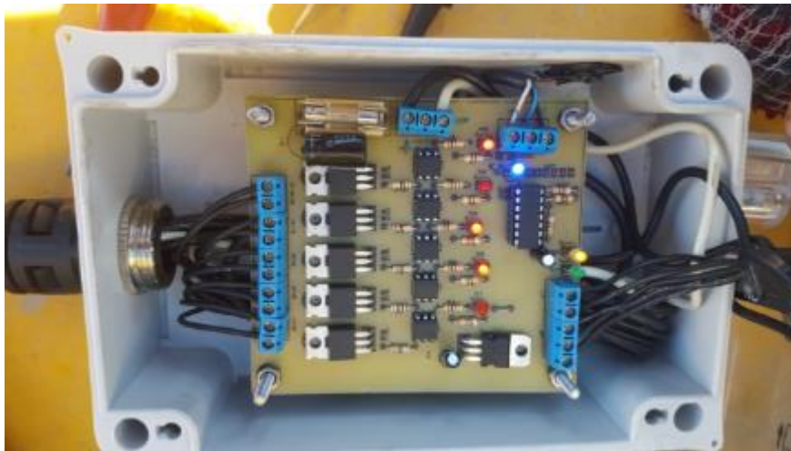
Figura. 38 Arnés de emergencia activado la función de bombeo en reversa Fuente: autor
