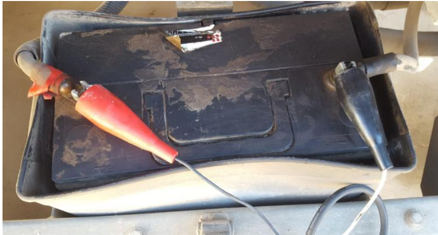
Figura. 31 Conexión del arnés automatizado a la fuente de energía de la bomba de hormigón Fuente: autor
