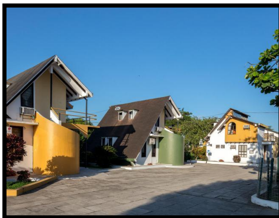
Figura 14 Hostería Amazonas Fuente: https://hosteriamazonas.com/wp/galeria/
