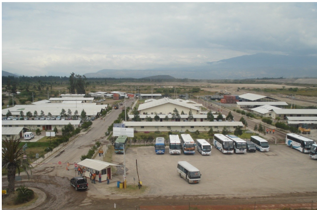
Ilustración 2 Campamento del nuevo Aeropuerto de Quito-Tababela – Carmen Urbina
