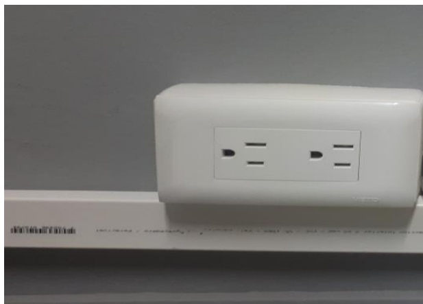
Figura. 4.11. Instalación de Tomacorrientes
