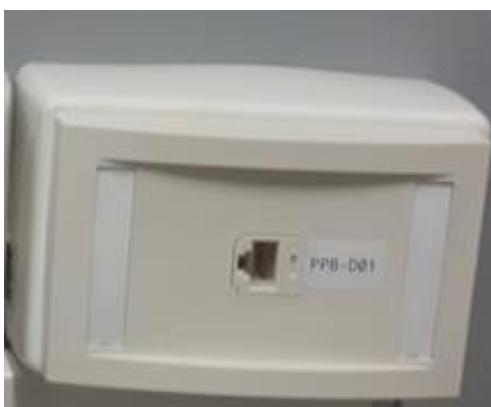
Figura. 4.13. Armado de Face plate
