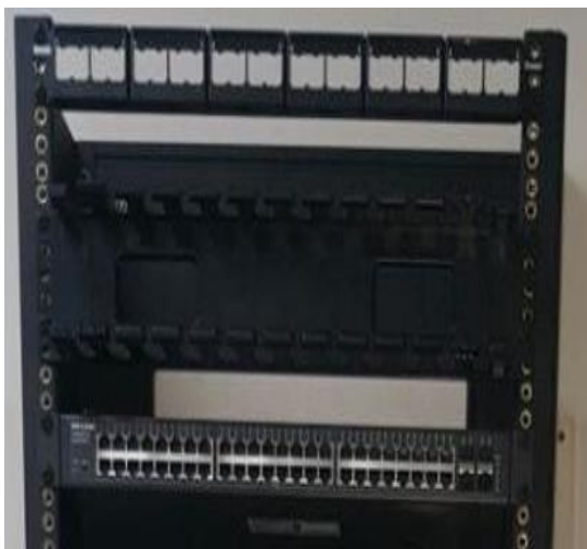
Figura. 4.14. Armado del rack de comunicaciones
