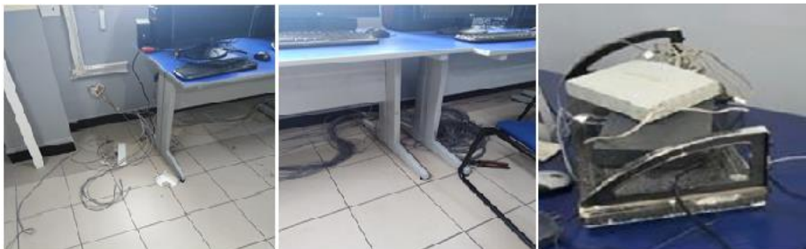
Figura. 4.8. Desmontaje de sistema existente
