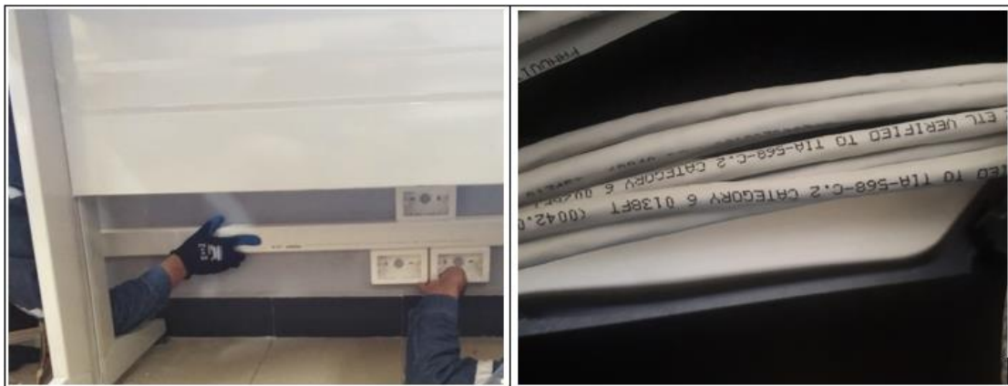
Figura. 4.10. Montaje de canaletas y cableado. Fuente: Elaborado por el Autor
