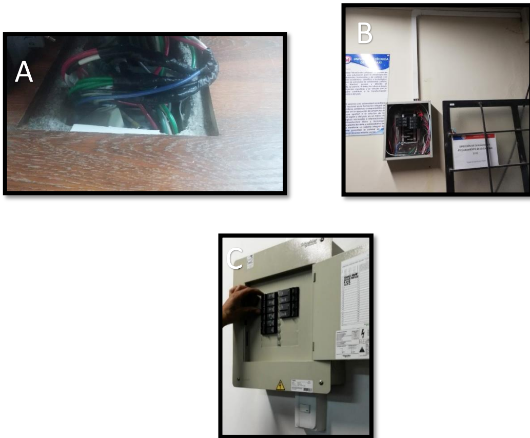
Figura 4.11. Proceso de cableado eléctrico Fuente: (Jínez, 2019)
