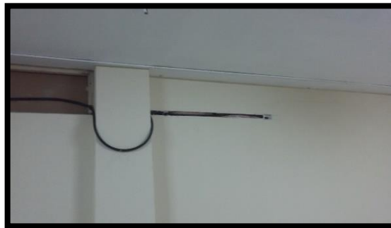
Figura 4.9. Colocación de mangueras y cajetines Fuente: (Jínez, 2019)
