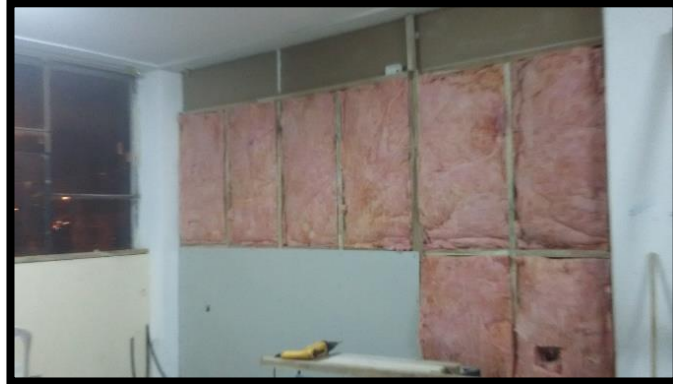
Figura 4.6. Adecuación de insonorización Fuente: (Jínez, 2019)
