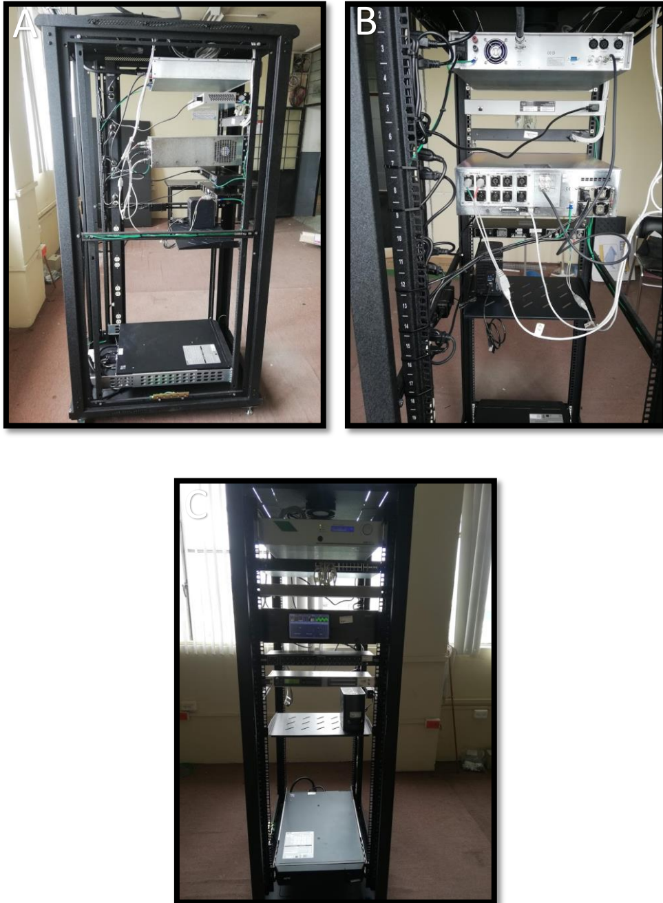
Figura 4.13. Adecuación del RACK Fuente: (Jínez, 2019)
