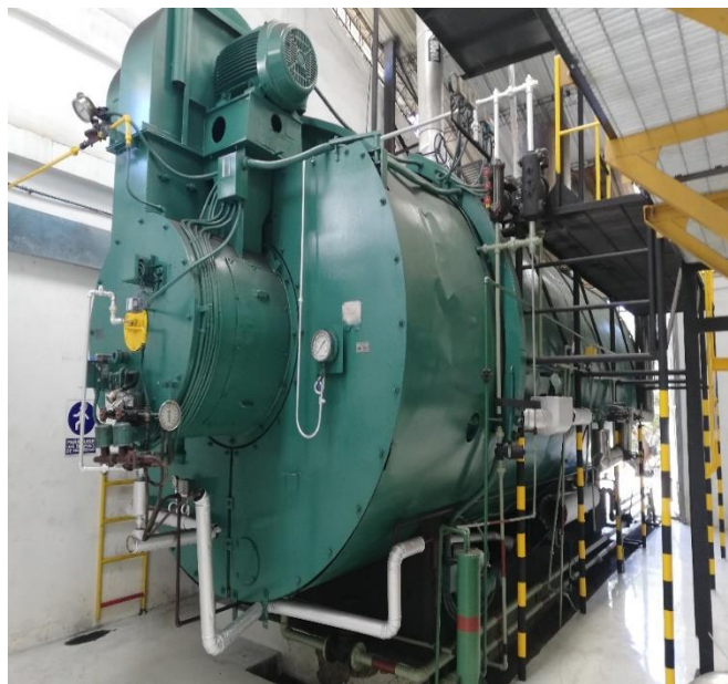
Figura 4. 14 Vista frontal de la caldera luego de la intervención realizada
