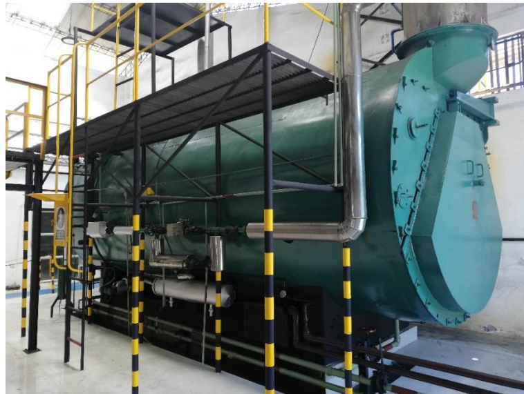
Figura 4. 12 Estado actual de la caldera
