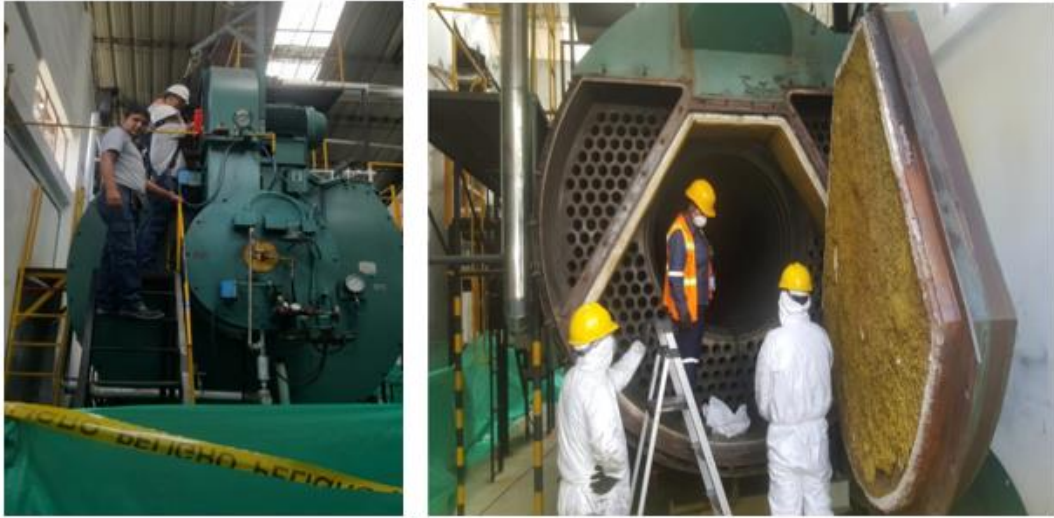
Figura 4. 11 Mantenimiento de la caldera
