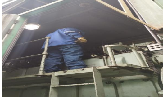
Imagen 5 Trabajos en altura
