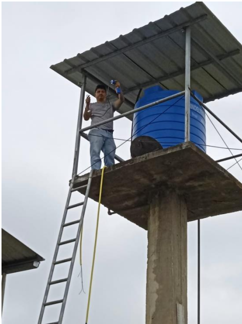
Instalación de sensor de nivel
