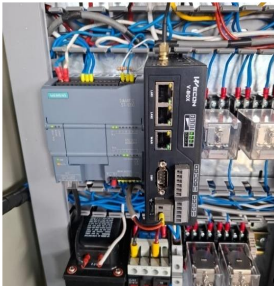
Montaje del Gateway V-BOX
