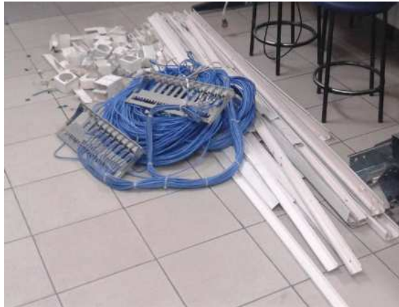
Figura 3.13 Escombros retirados de la red antigua
