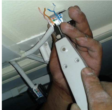
Figura 3.29 Ponchado de hilos Fuente: El autor
