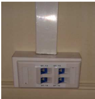
Figura 3.31 Puntos de red terminados Fuente: El autor
