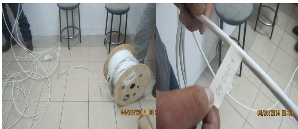
Figura 3.23 Corte y etiquetado provisional del cable UTP
