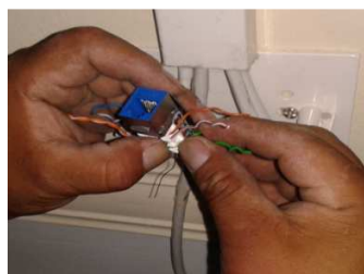
Figura 3.28 Distribución de hilos en el jack Fuente: El autor
