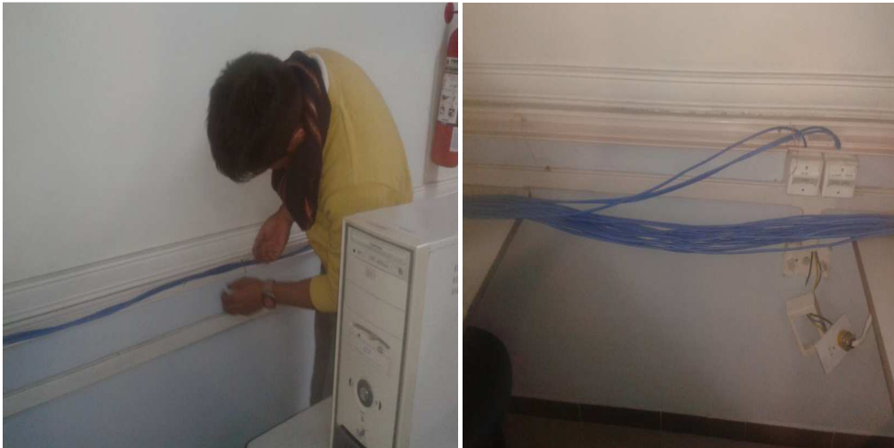
Figura 3.11 Retiro del cable de datos Fuente: El autor
