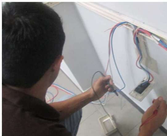
Figura 3.12 Pruebas del cableado eléctrico Fuente: El autor
