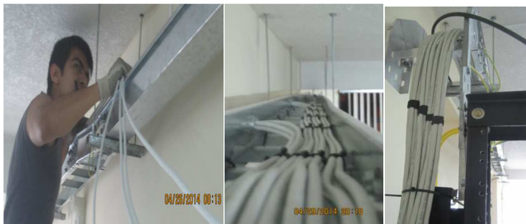
Figura 3.24 Tendido y peinado de cables
