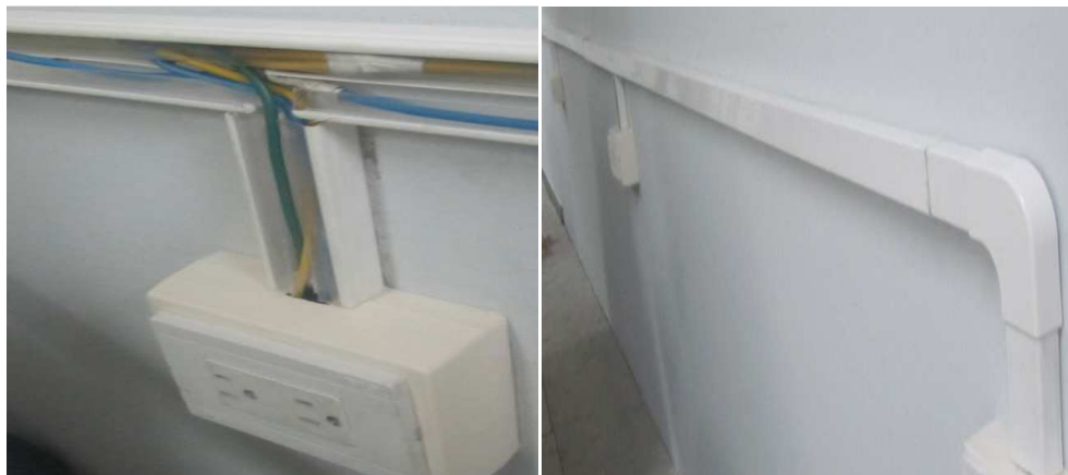
Figura 3.15 Nuevo cableado eléctrico Fuente: El autor
