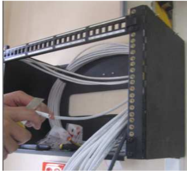
Figura 3.33 Ponchado en el patch panel Fuente: El autor
