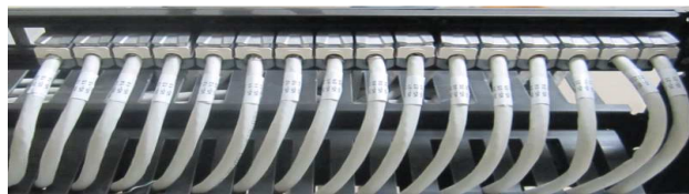
Figura 3.35 Patch Panel listo Fuente: El autor
