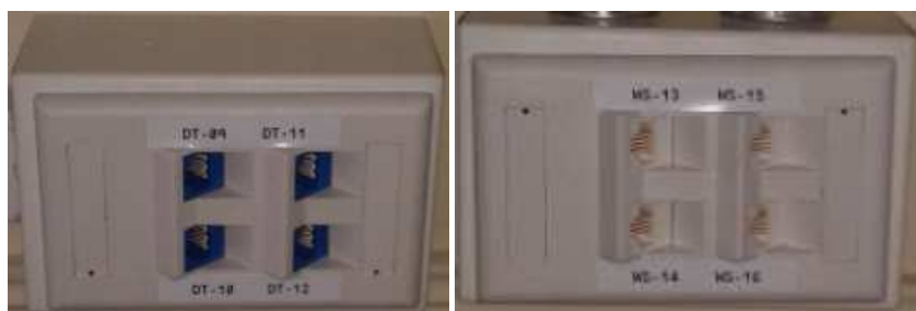
Figura 3.38 Face Plate etiquetados
