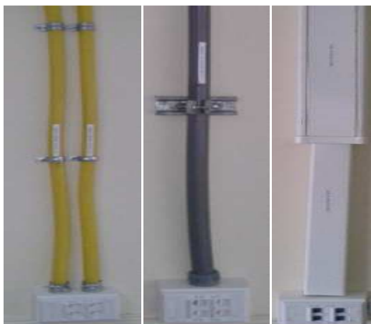
Figura 3.37 Ductos etiquetados
