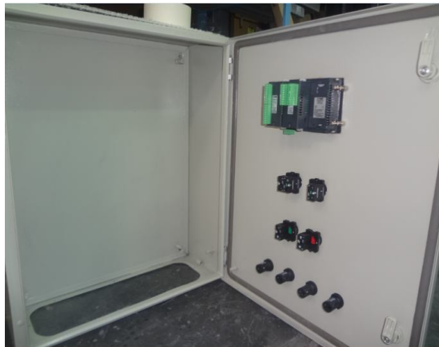
Figura 3.36 Fijación de PLC y demás accesorios (Fuente: Autor)
