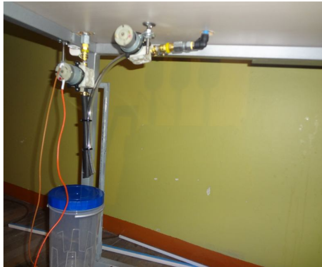
Figura 3.51 Fijación de las bombas de agua (Fuente: Autor)
