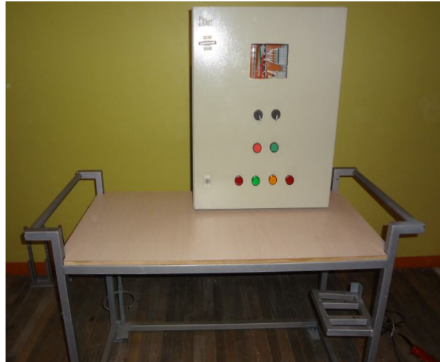
Figura 3.46 Montaje del tablero en la mesa de trabajo (Fuente: Autor)
