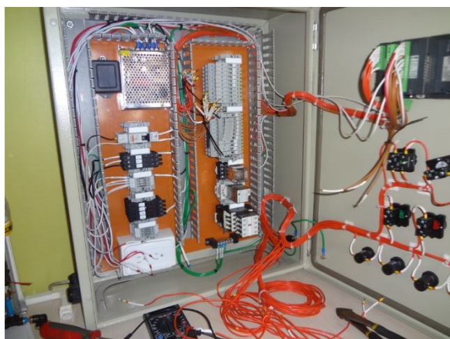
Figura 3.40 Conexiones finales (Fuente: Autor)
