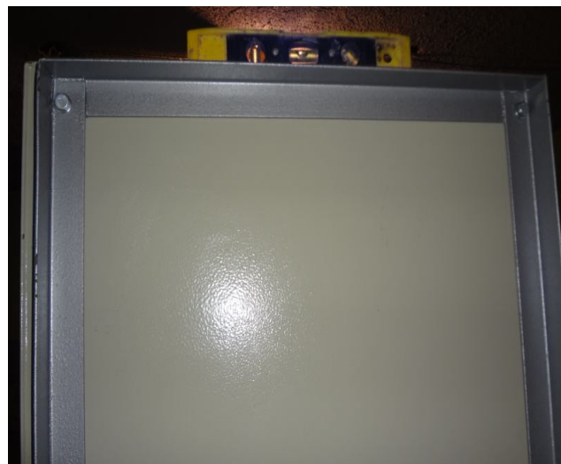
Figura 3.47 Fijación y nivelación del tablero (Fuente: Autor)
