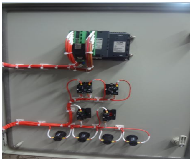
Figura 3.39 Peinado y fijación de cables (Fuente: Autor)
