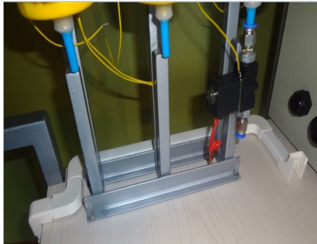
Figura 3.49 Colocación de electroválvulas (Fuente: Autor)
