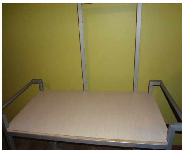
Figura 3.45 Fijación de plancha de madera en mesa metálica (Fuente: Autor)
